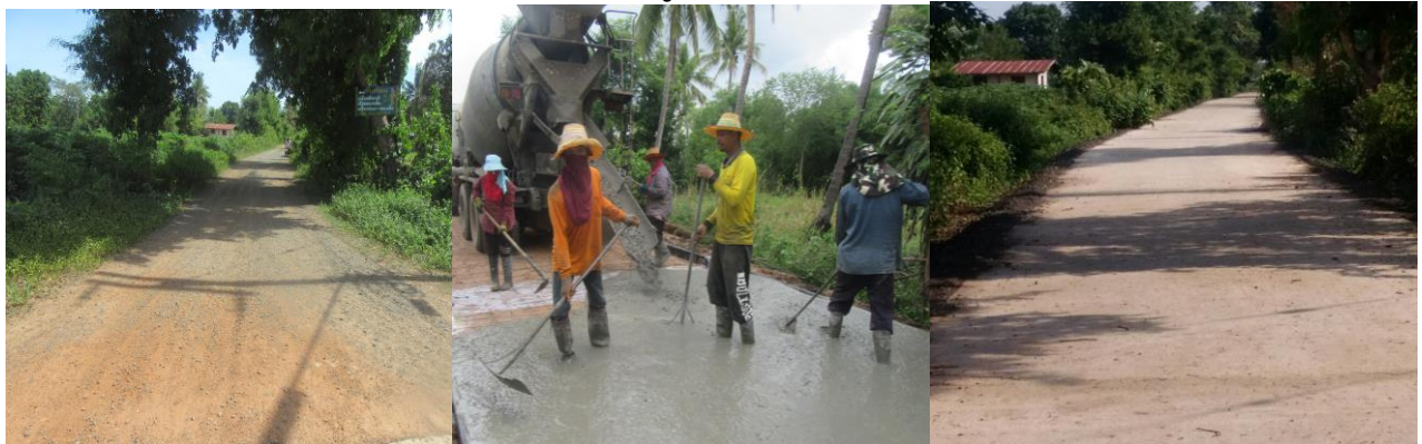
โครงการก่อสร้างถนนคอนกรีตเสริมเหล็ก หมู่ที่ 8 เชื่อมจากถนนหลัก - บ้านนายแปลก ผลจันทร์งาม
